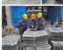
袁绪良在检修现场工作
