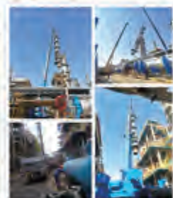
袁绪良在检修现场工作
